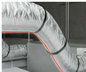
배관에 센서를 설치
